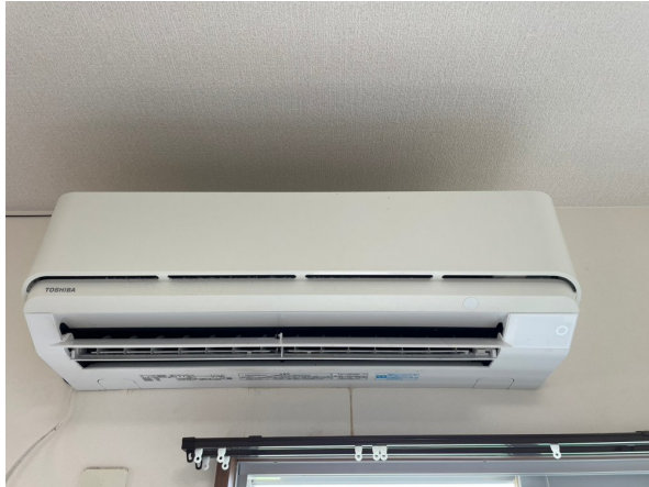
18.エアコンクリーニング
