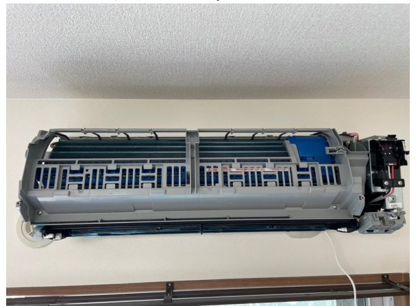
18.エアコンクリーニング
