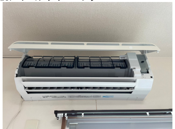
18.エアコンクリーニング
