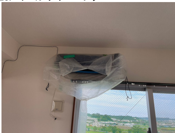
18.エアコンクリーニング
